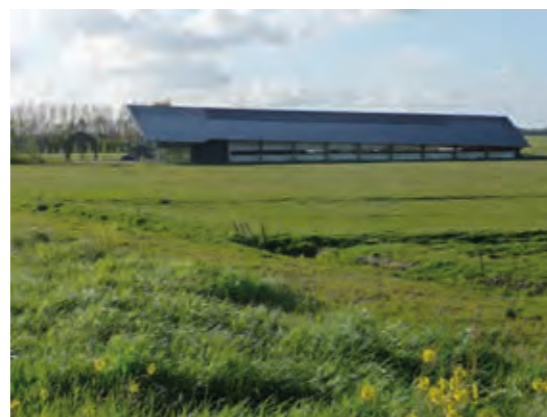
Voorbeelden: Nieuwe stal met architectonische kwaliteit in Zwartsluis
